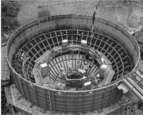
(BHKW) wird ebenfalls die Wärmeproduktion erhöht, die wiederum zur Erwärmung der Faultürme (ca. 37 Grad) Verwendung findet. Diesbezüglich muss weniger Heizöl zugekauft werden. Der Neubau eines dritten Faulturmes bringt sowohl betriebstechnische als auch wirtschaftliche Vorteile mit sich. Zur Bauausführung kommt ein Zylinder mit trichterförmiger Sohle. Diese etwas aufwändigere Bauweise entspricht den bestehenden Faultürmen
