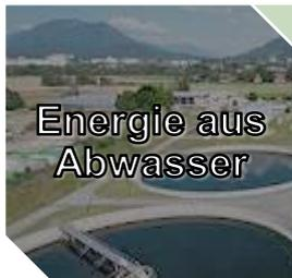
*Auch aus Abwasser kann Wärme gewonnen werden. Voraussetzungen dafür sind eine **Abwassermenge von mind. 5000 Personen**, ausreichend große Wärmeabnehmer mit mind. **150 kW Heizlast**, der Einsatz von **Flächenheizungen** mit Vorlauftemperaturen mit **max. 30 °C**, sowie kurze Entfernungen der Wärmeabnehmer zur Kanalisation (**max. 300 m**) (LfU, 2015).*
